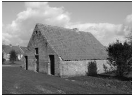
Het geklasseerde bakhuis te Kessel
