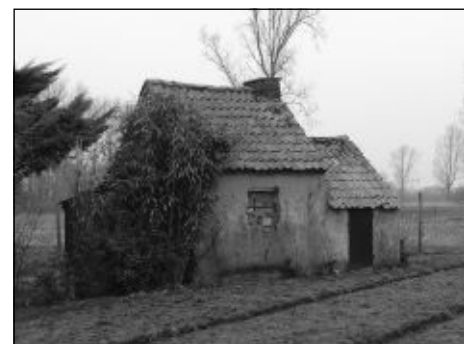
Restanten van een oud bakhuisje op de Laakhoeve te Nijlen.
