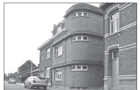
Pakketboothuis in de Spoorweglei 29.
