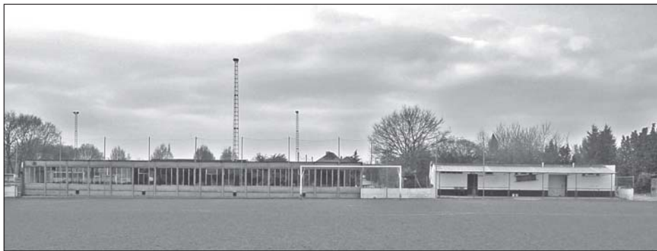
De oude kantine en de kleedkamers van het A-terrein maken plaats voor een nieuw complex bij KFC Bevel...
