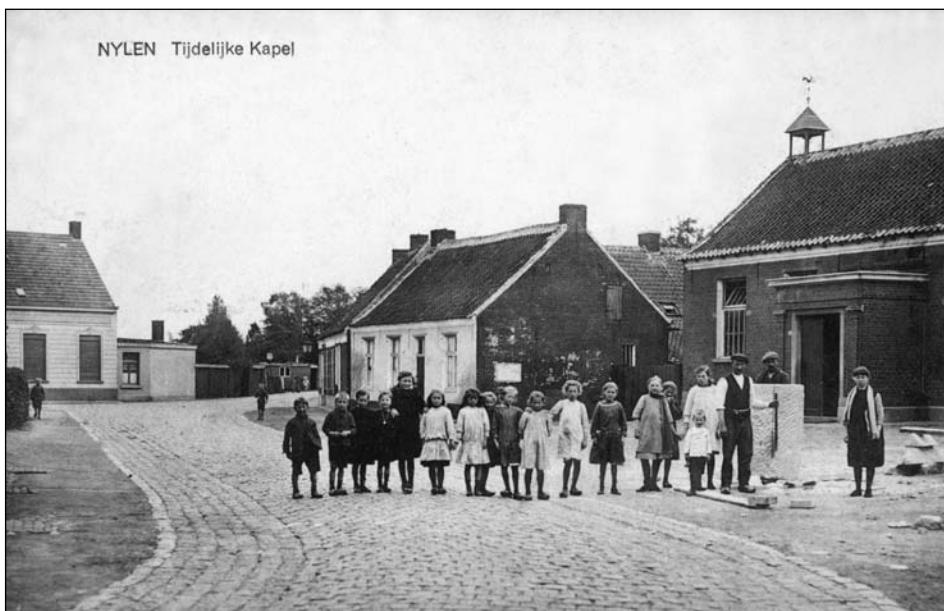
Overleefde de zusterschool de Grote Oorlog zonder veel problemen, dan was dit zeker anders voor de Willibrorduskerk, die in oktober 1914 totaal uitbrandde (zie ook De Poemp nr. 43). Op deze foto uit 1927 zien we de "tijdelijke kapel", ongeveer op de plaats waar vandaag het gemeentehuis staat.
