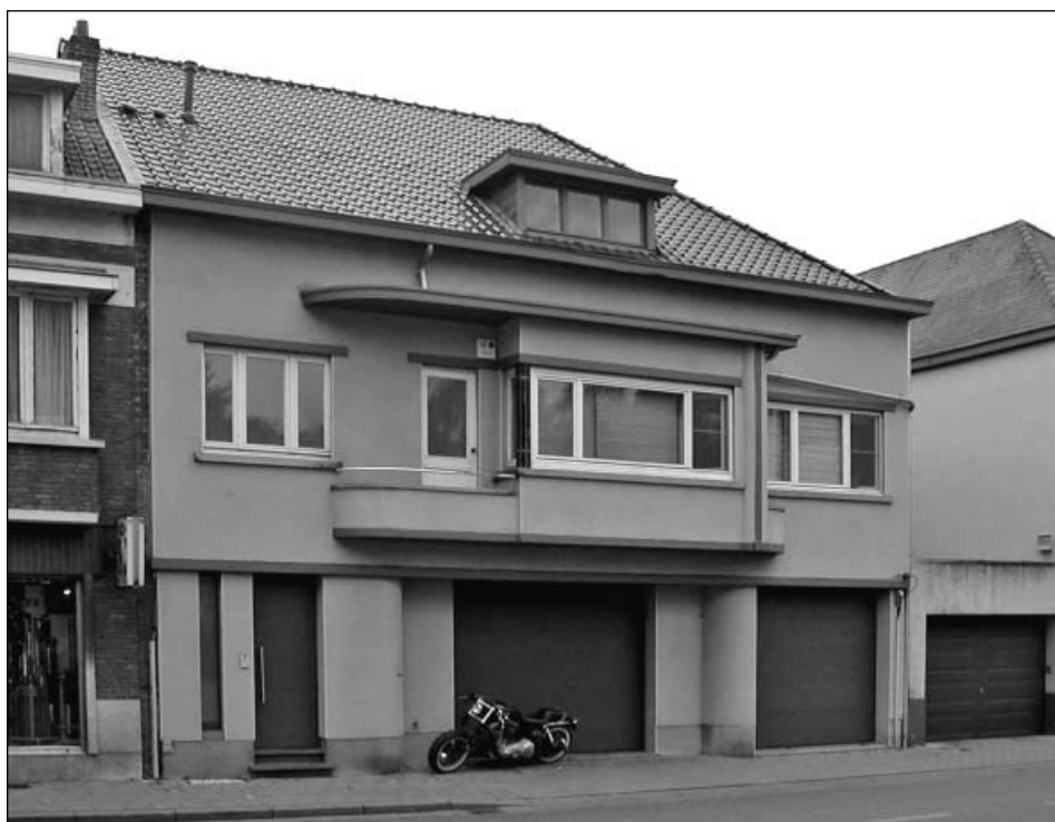
In 1939 bouwde August Van Eester deze woning in de Albertkanaalstraat. Zij werd recent gerenoveerd.
