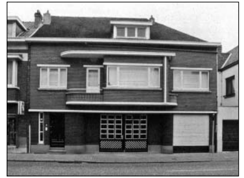
De woning in de Albertkanaalstraat nummer 32, voor de renovatie.
