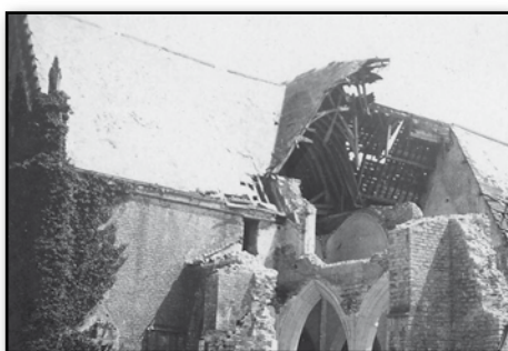
De dynamitering van de Kesselse Salvatorkerk richtte zware schade aan.
