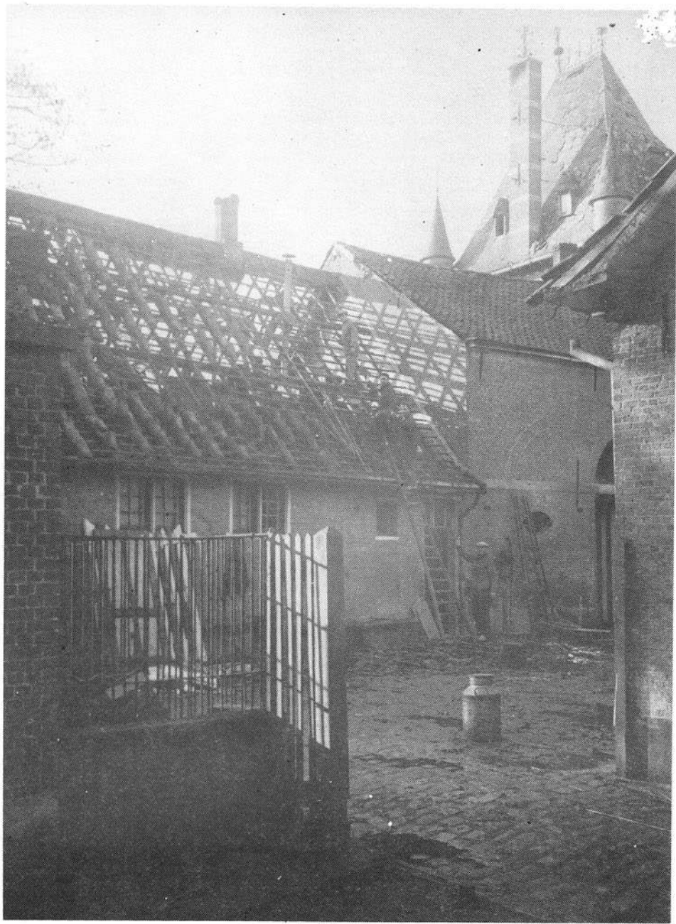
Achtergevel van de boerderij van het kasteel.
