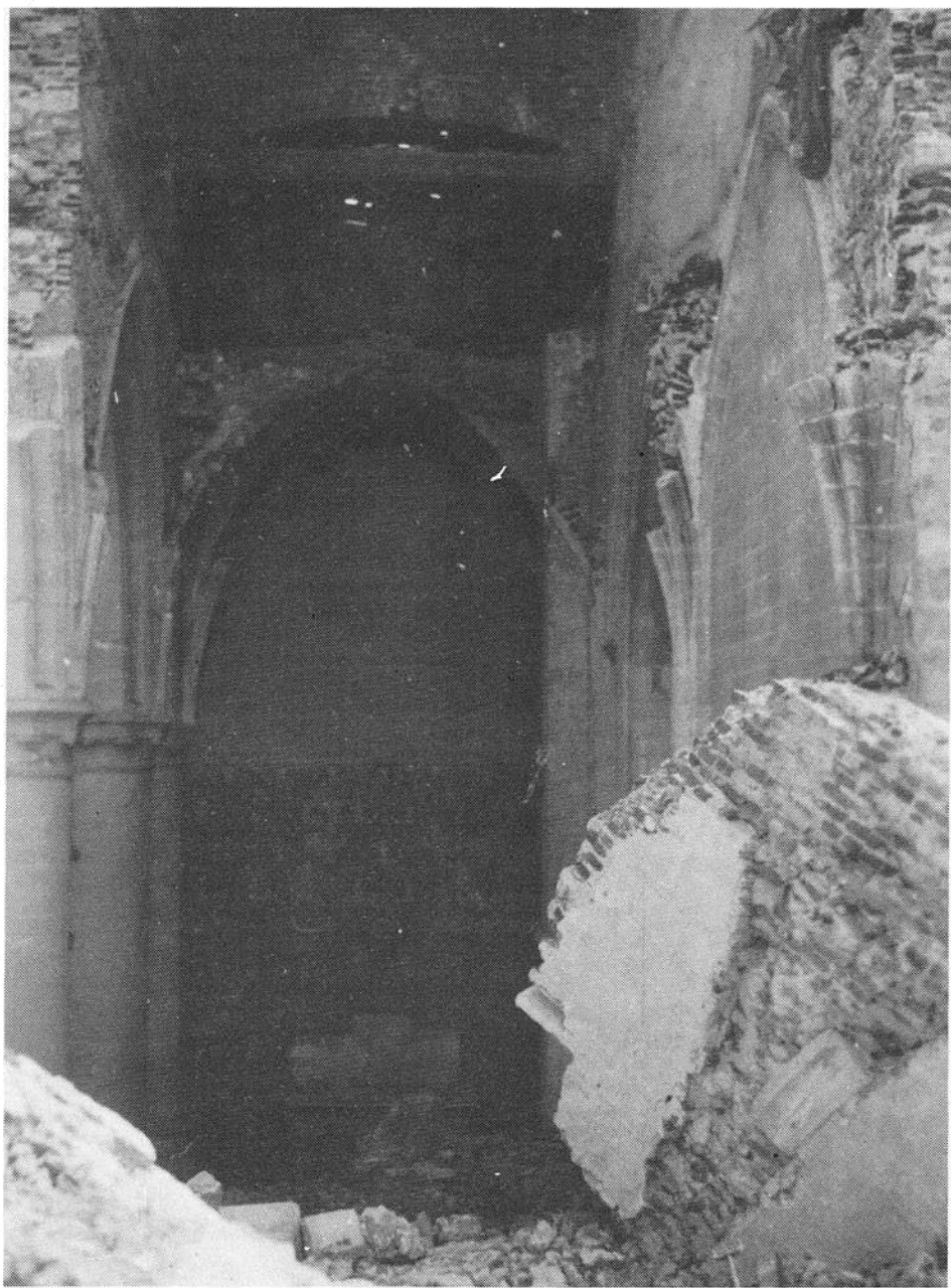
De gewelven van de rechter zijbeuk waren met het springen van de toren ingestort. In de achtergrond het altaar van het H.Hart. Achter de grote steenblok bevindt zich de preekstoel.
