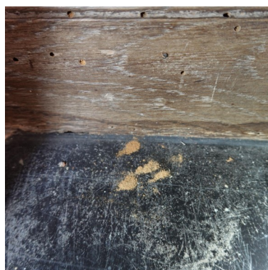
Uitvliegopeningen en boormeel van de grote houtwormkever
